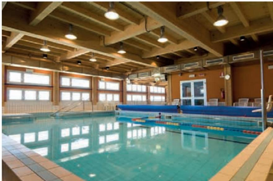
Moretti Interholz ha dato vita al telaio strutturale dell'edificio con una teoria di montanti in legno lamellare incastrati al piede con acciaio inox.
