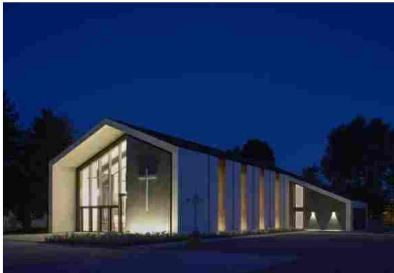
Luce e trasparenza sono garantite dalle **vetrate**, a tutt'altezza, presenti sulla facciata principale e sulle laterali. Un ampio porticato e la profondità degli imbotti (1 m) nella scansione dei fianchi garantiscono l'ombreggiamento: una buona protezione dall'irraggiamento solare nelle ore centrali della giornata, mentre l'altezza delle aperture assicura un'efficace illuminazione in profondità sino alla parte centrale della navata.
