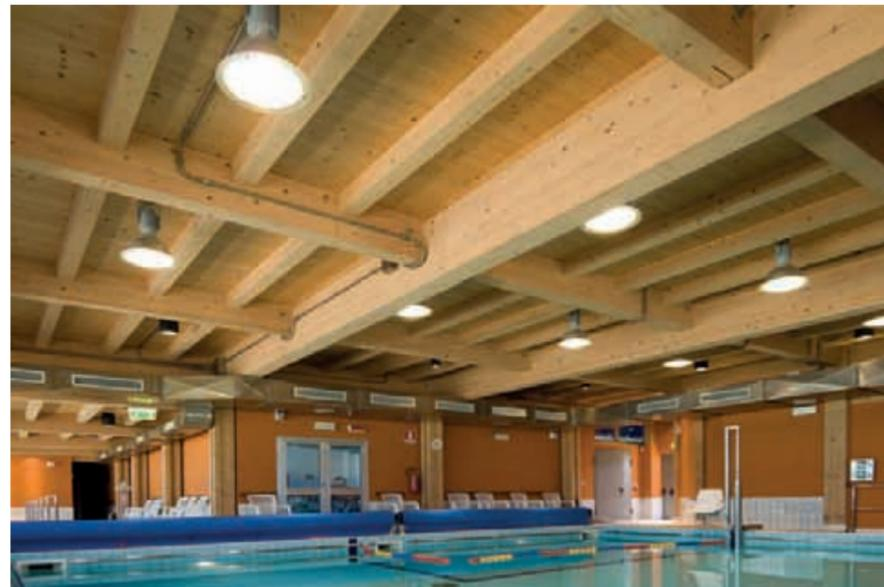
di varia sezione che portano, in selle ricavate nel legno, l'orditura finale di correnti. La pannellatura verticale non concorre alla controventatura di parete mentre quella orizzontale irrigidisce il piano. La struttura ha resistenza al fuoco R60.
