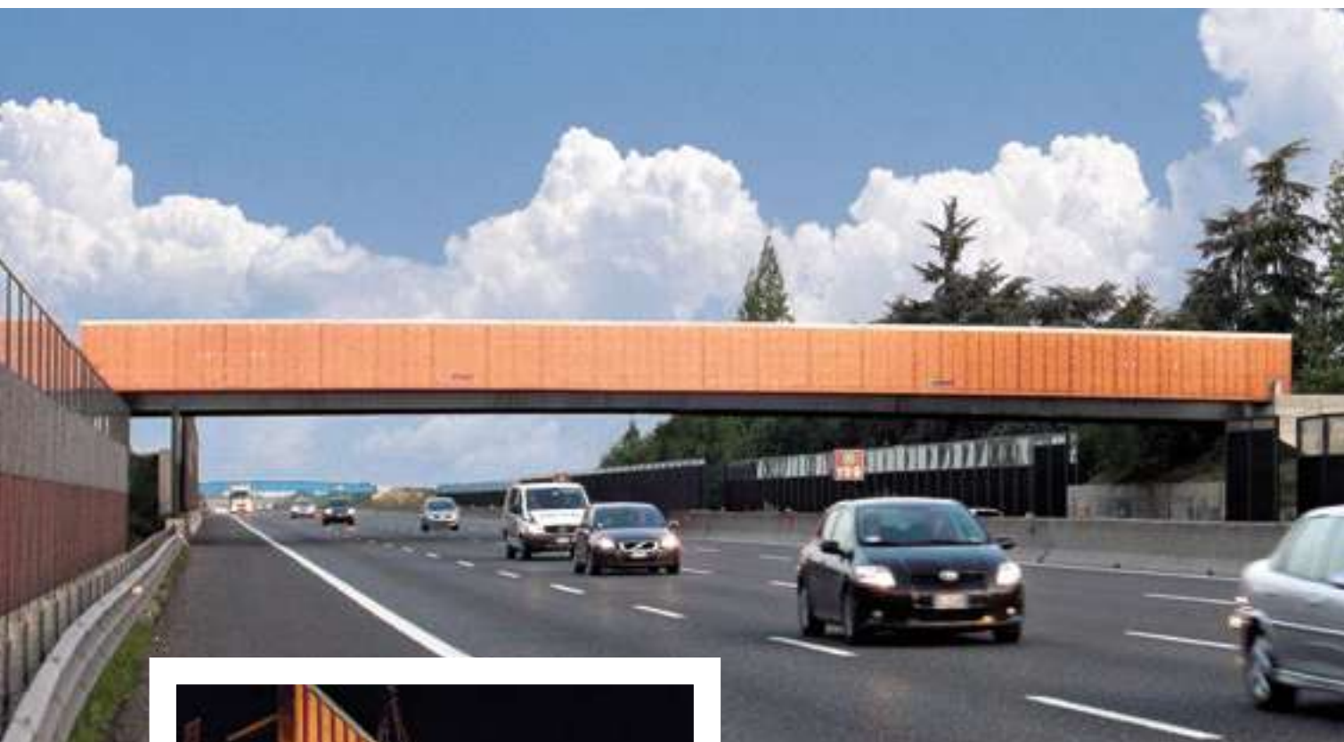
Ponte ciclopedonale sull'Autostrada A1 - S.Cesario (MO) - Italia
