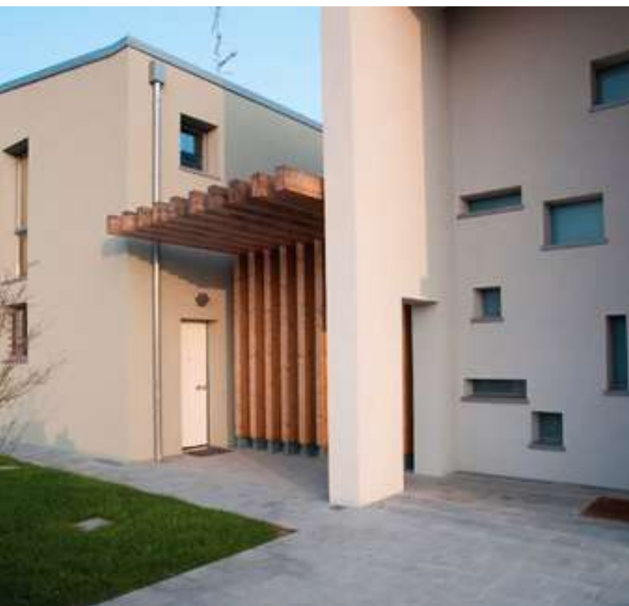
Abitazione privata - Rolo (RE) - Italia
