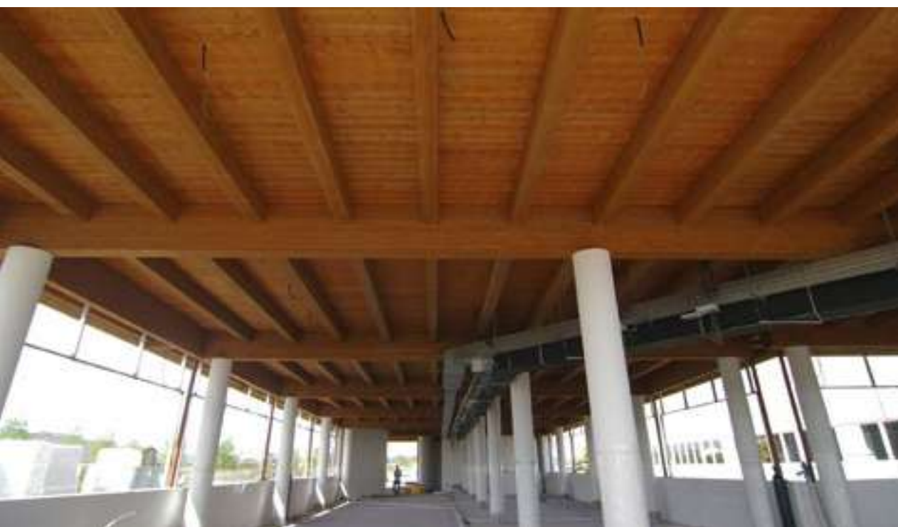
Capannone industriale Forlì (FC) - Italia
