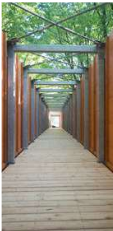
Ponte pedonale San Cesario (MO) Italia
