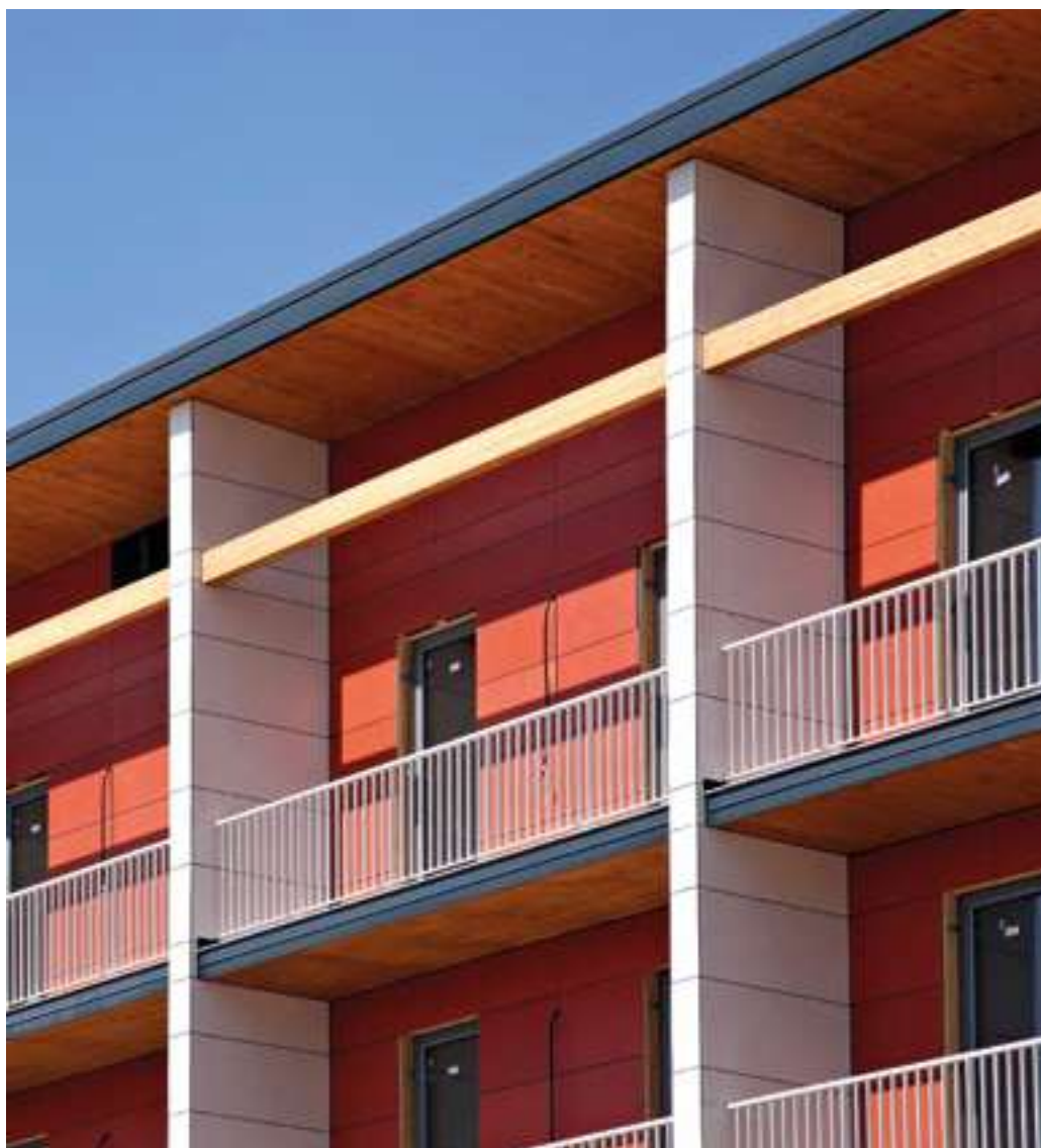
Progetto C.A.S.E. Ricostruzione post terremoto dell'Abruzzo Italia
