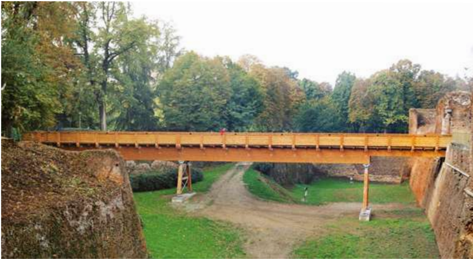
Passerella pedonale - Novara (NO)- Italia
