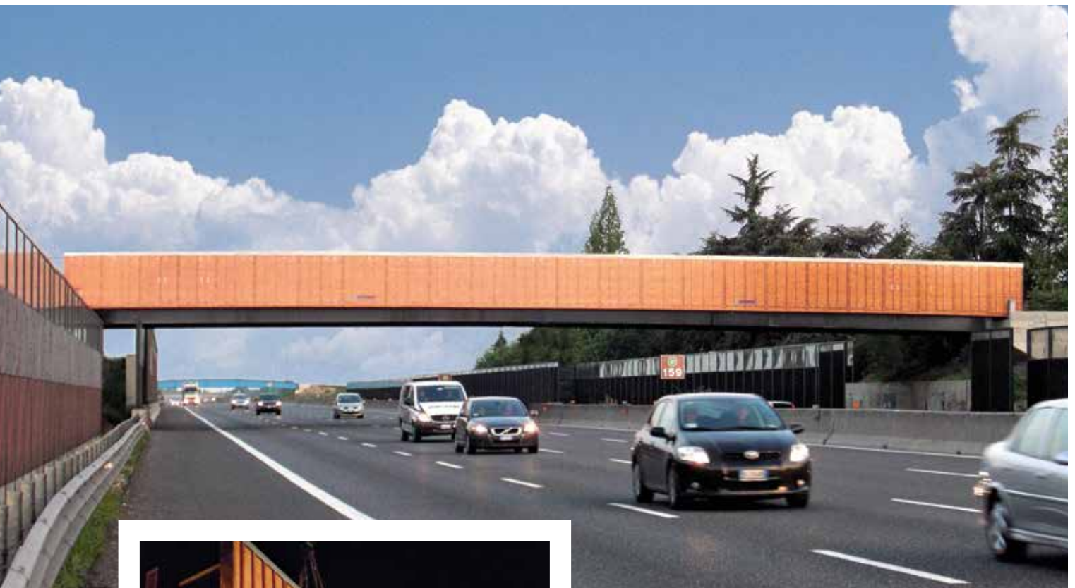
Ponte ciclopedonale sull'Autostrada A1 - S.Cesario (MO) - Italia
