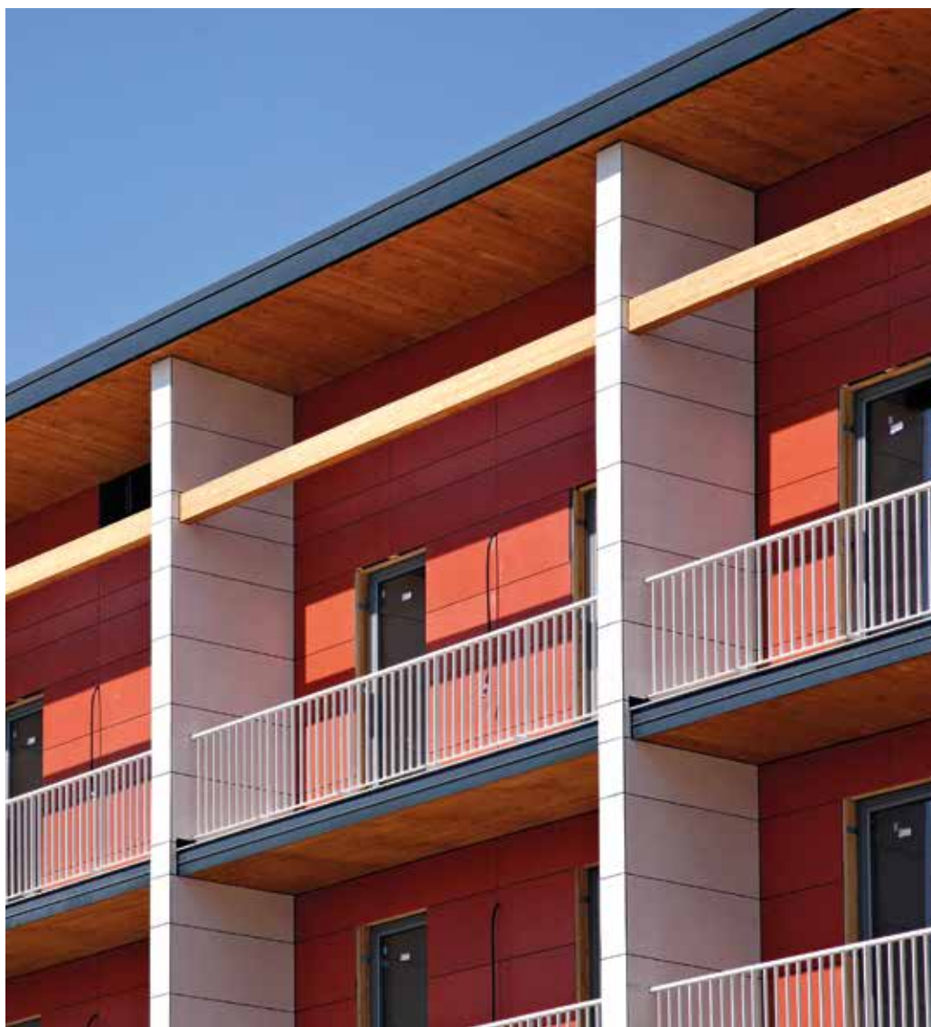
Progetto C.A.S.E. Ricostruzione post terremoto dell'Abruzzo Italia
