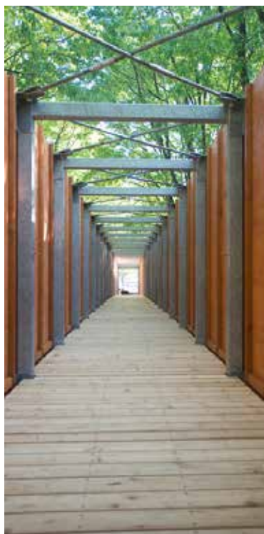
Ponte pedonale San Cesario (MO) Italia
