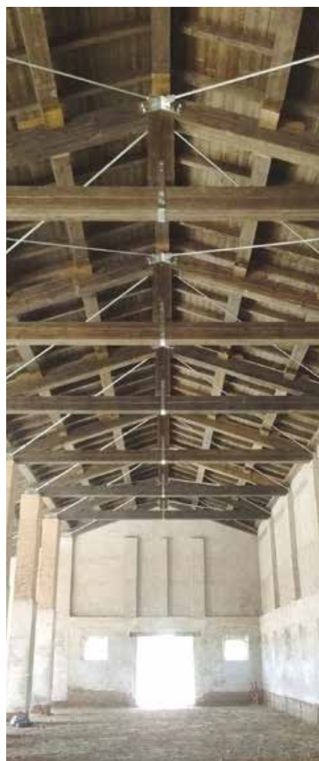
Copertura Agenzia Consorzio Agrario Pianoro (BO) - Italia
