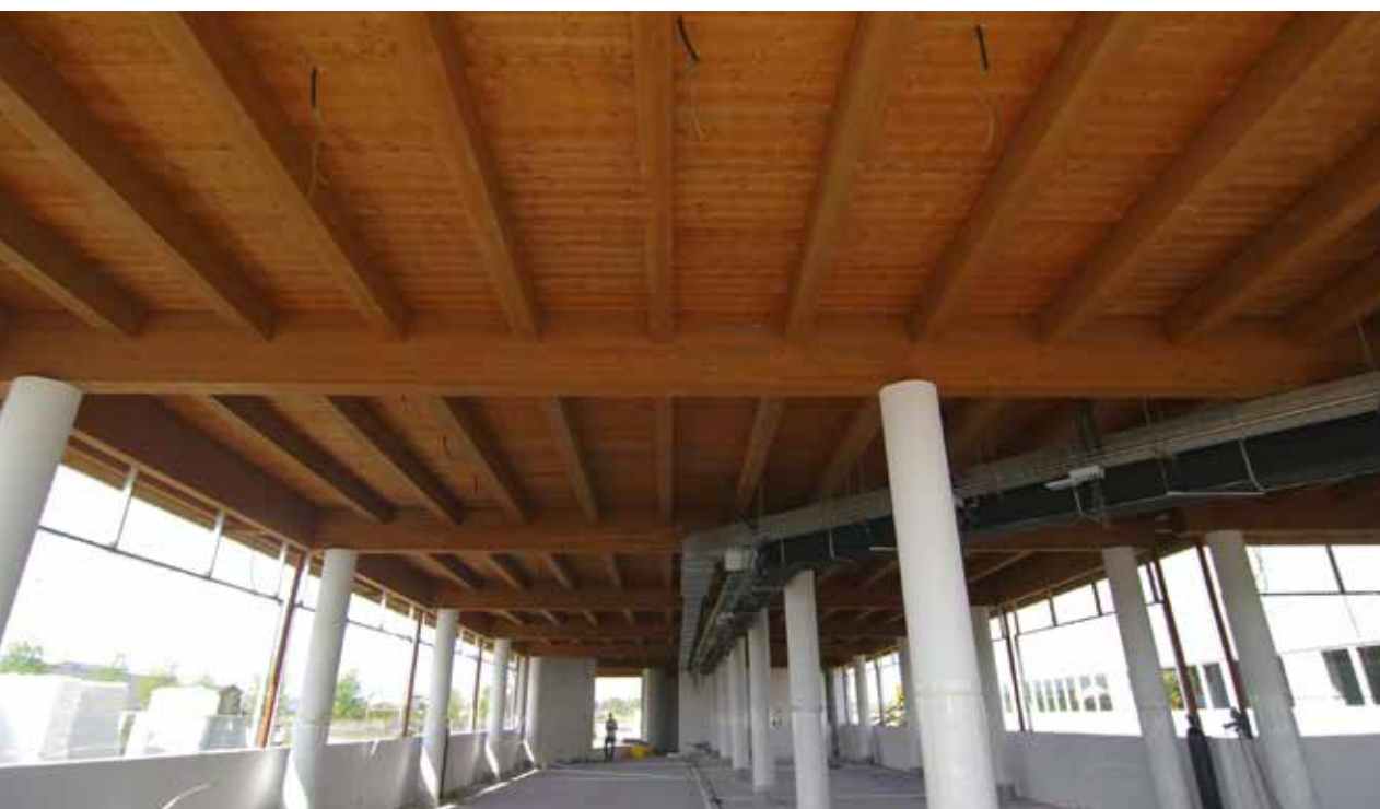
Capannone industriale Forlì (FC) - Italia
