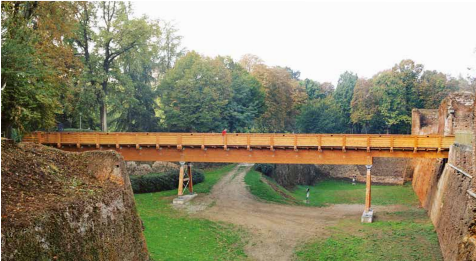
Passerella pedonale - Novara (NO)- Italia
