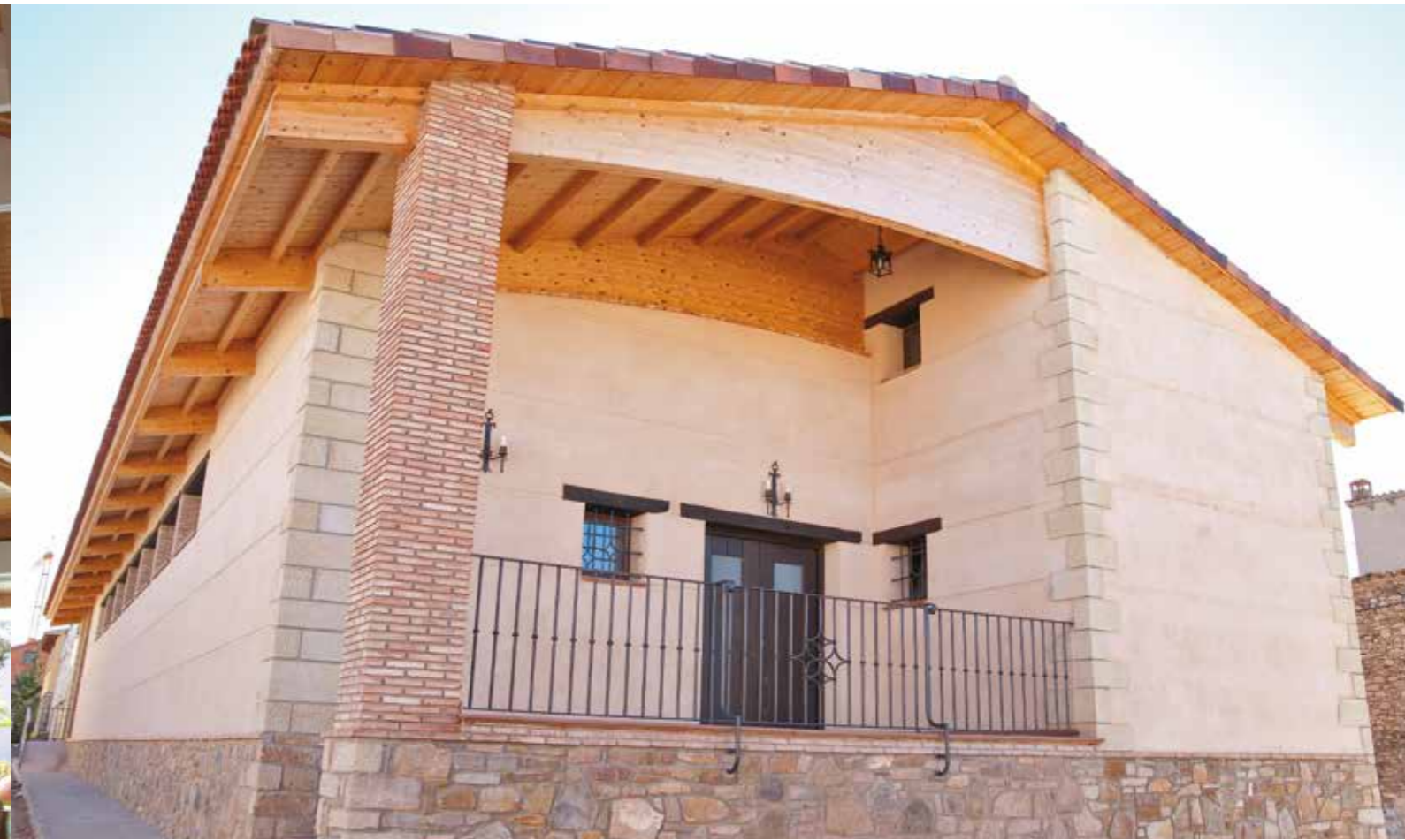
Edificio multiuso - Valbona (Teruel) - Espana
